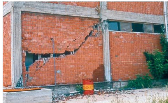
الشكل (22-2): انهيار جدار البلوك على القص تحت تأثير حمولات زلزالية
