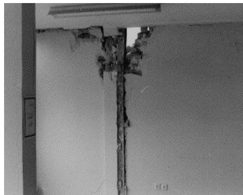
الشكل (27-2): تكسر الزوايا على طرفي حقل الضغط في جدار البلوك نتيجة زلزال مانجيل راودبار ( Memari et al.,1999 )
