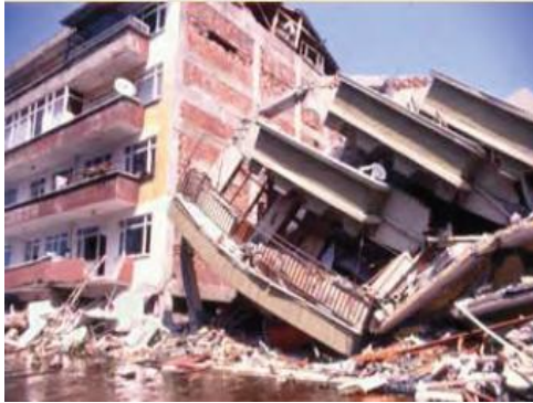
(b) الانهيار المفاجئ لمبنى نتيجة زلزال تركيا ١٩٩٩ (Gulkan et al , 2002)
